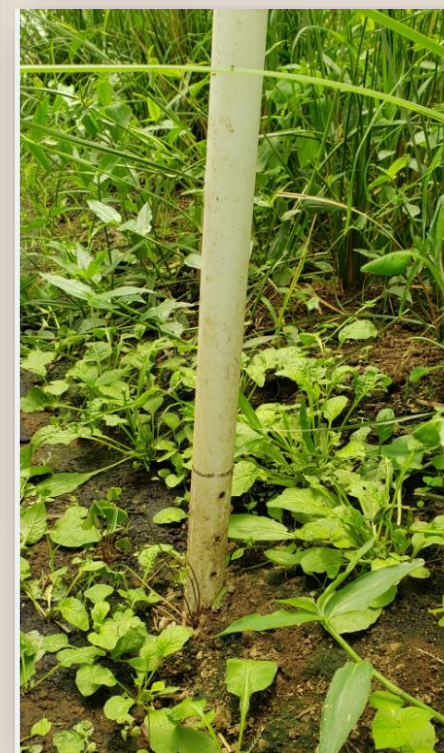
Tubería de aireación
