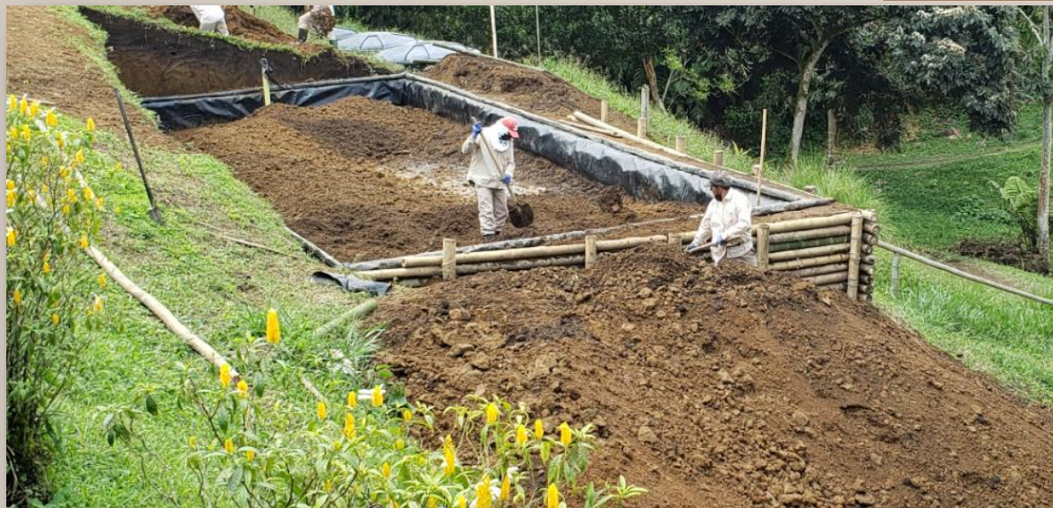
Llenado de la excavación
