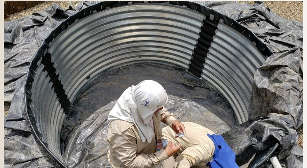
8. Instalación del tanque de drenados
