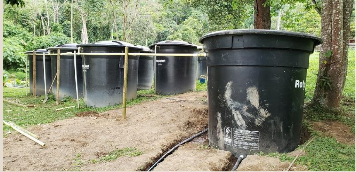
6. Canalización del agua del SMTA al FV
