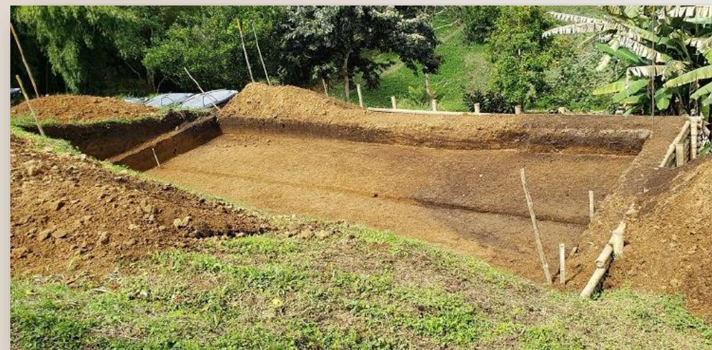
Excavación de 0,70 m
