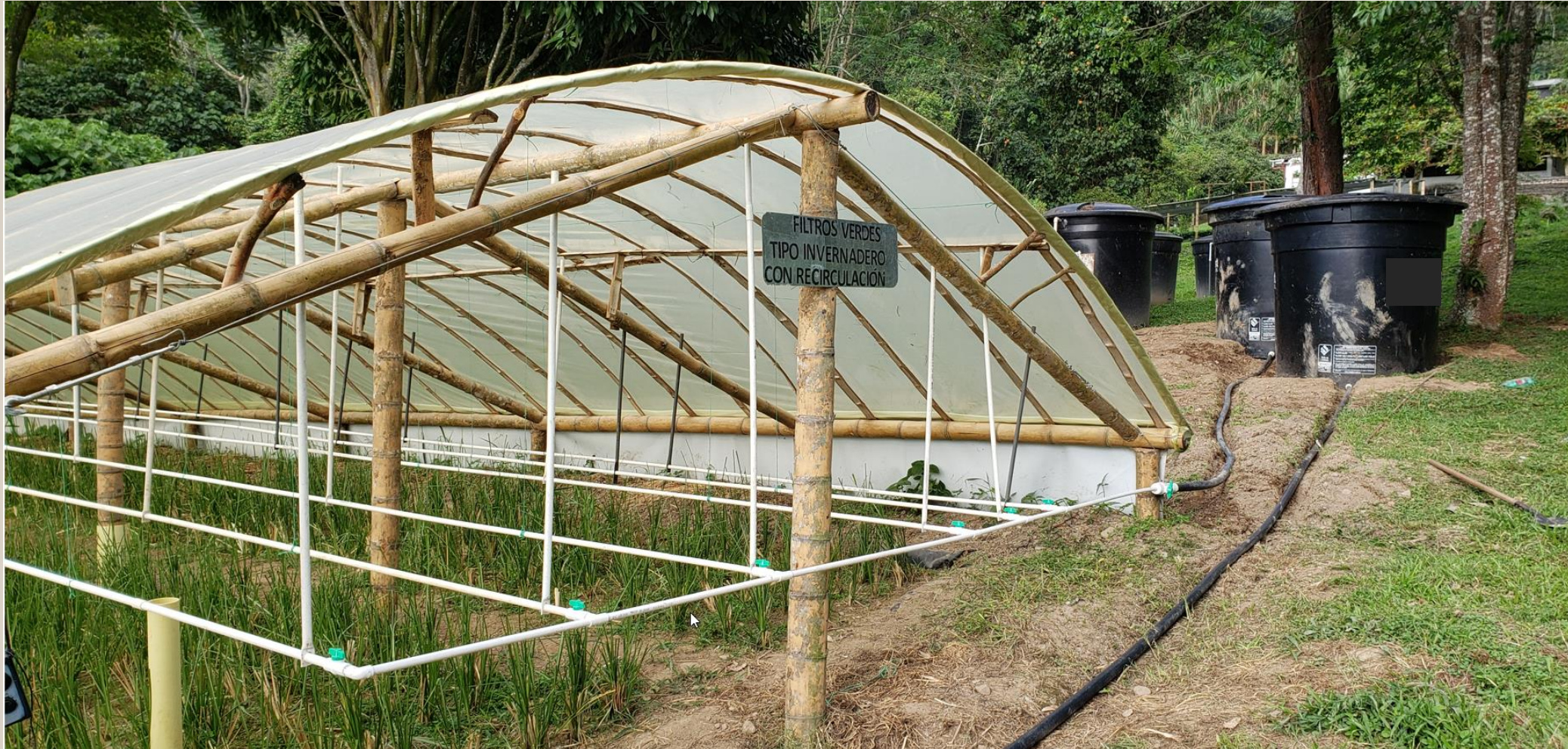
Filtro verde beneficiadero experimental Cenicafé. 200 m 2 10.000@ cps/año. Operando desde 2019
