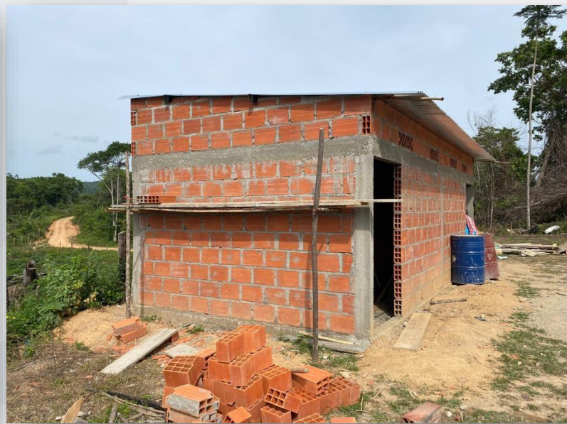
Construcción unidad sanitaria
