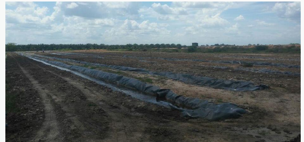
Foto: Alianza del Humea S.A.S, Construcción de los canales de sedimentación
