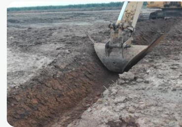
Figura 1. Construcción del sistema de canales para el establecimiento de los humedales: 12 canales con una longitud de 200 m.
