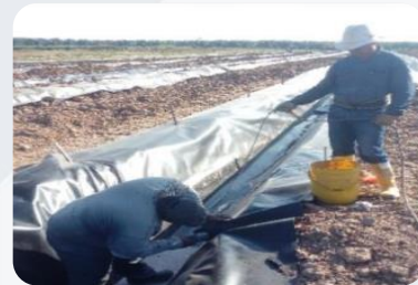
Figura 1. Construcción del sistema de canales para el establecimiento de los humedales: 12 canales con una longitud de 200 m.
