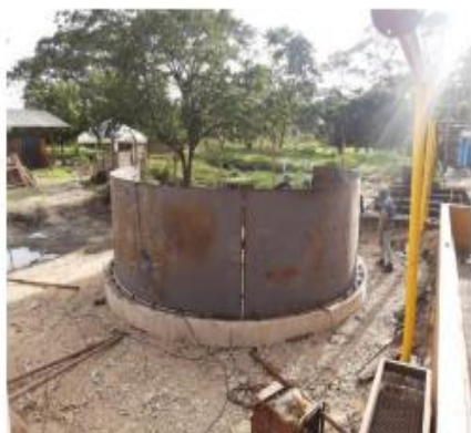
Inicio de montaje tanque de almacenamiento 1
