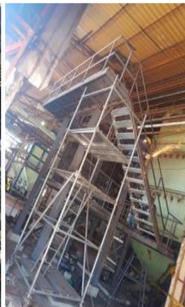
Estructura de clarificación
