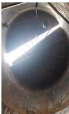
Techo del tanque de almacenamiento 2
