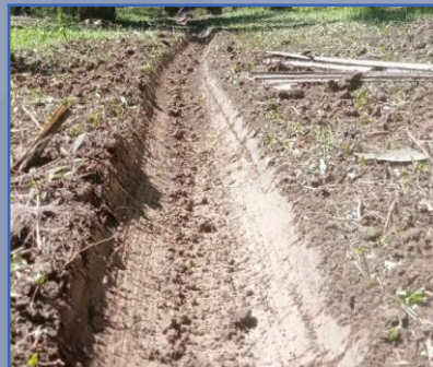
Drenajes y Riego
